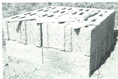
Abb. 5: Ein Fundament aus zwei Schichten Hohlblocksteinen. Hier ist gut zu sehen, daß in der zweiten Schicht die Fugen quer zu denen der unteren verlaufen.
