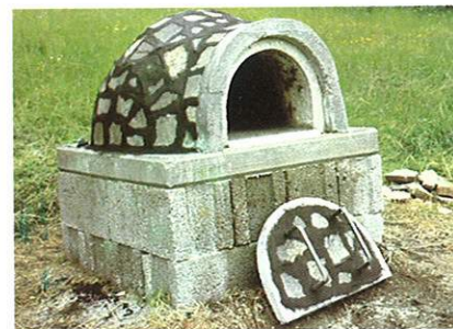
Abb. 20: Der fertige Ofen mit Tür. Deutlich sieht man im Ofeninneren die Schamotteschicht auf der Bodenfläche.
