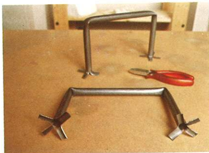
Abb. 19: Als Griffe werden zwei Rohrstücke in die Tür miteingegossen. Vorher werden die Enden aufgespreizt, damit die Griffe fester sitzen.
