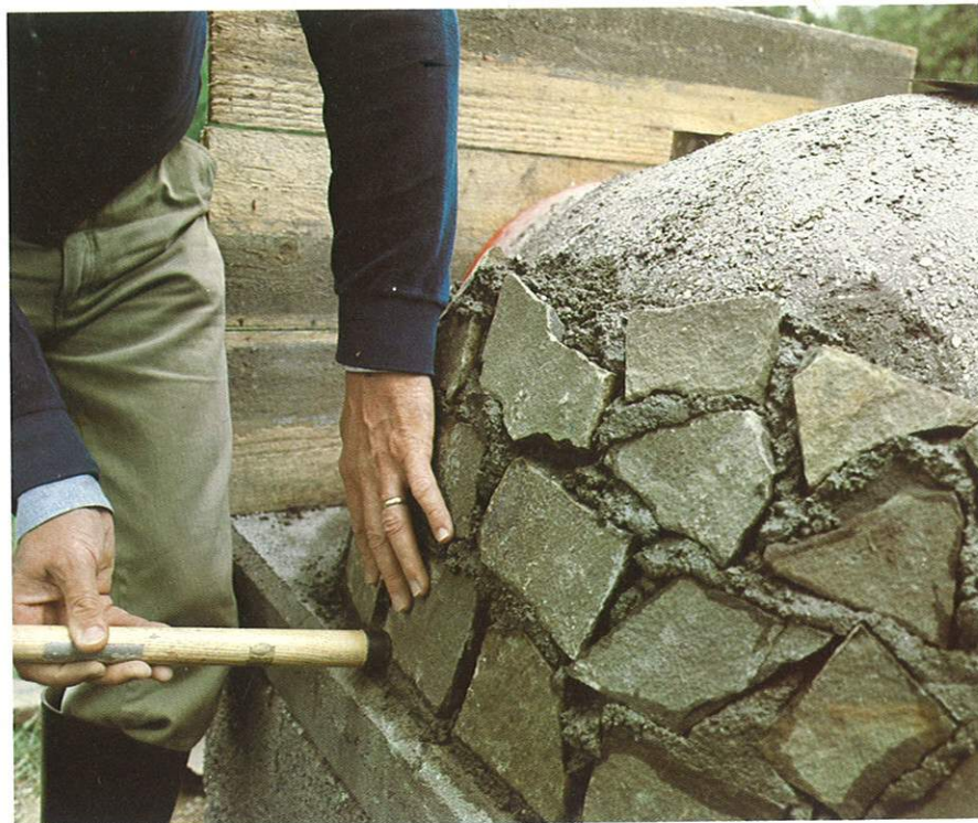
Abb. 17: Eine Möglichkeit, die Betonkuppel mit Natursteinen ansprechend zu verkleiden.
