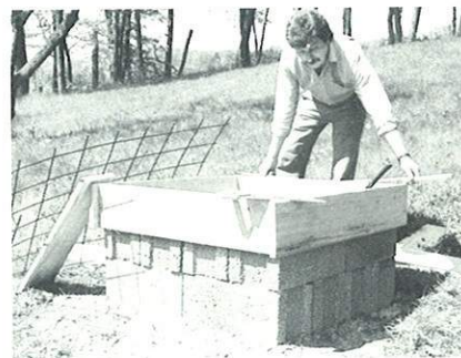
Abb. 6: Hier wird die Verschalung für die Betonplatte auf den Fundamentsteinen angebracht.
