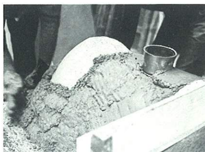
Abb. 15: Die erste Schicht (die Feuerbetonstampfmasse) wird auf den Formkern aufgebracht.
