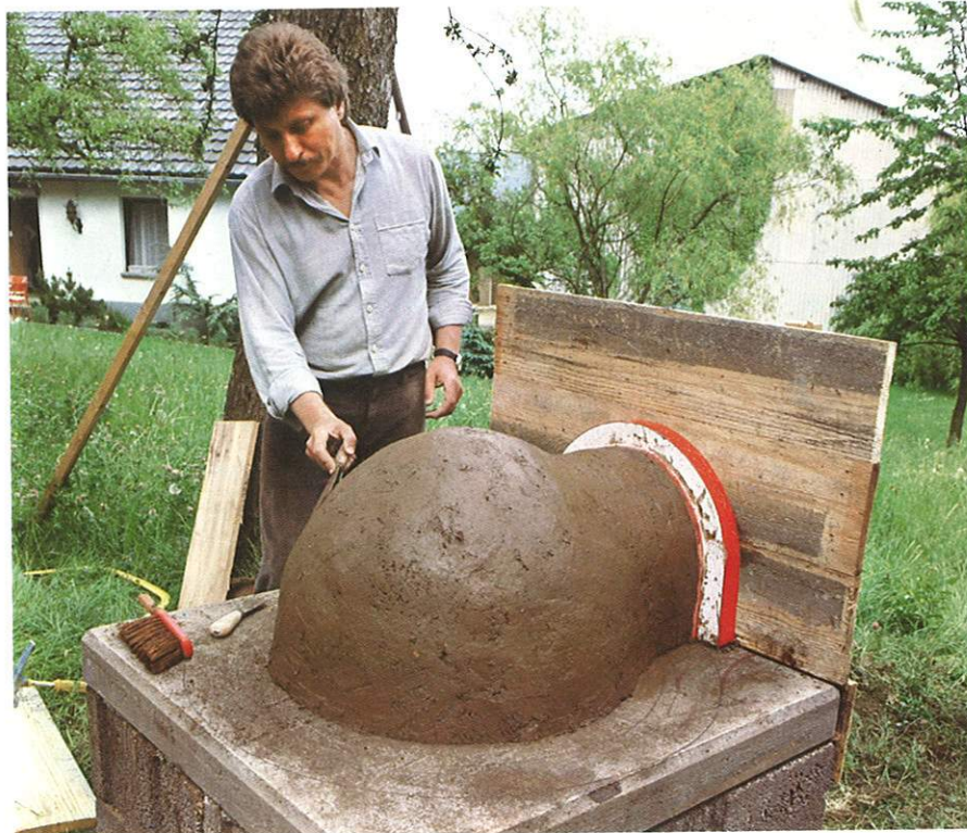
Abb. 13: Der Formkern des Ofens wird aus feuchtem Sand hergestellt.
