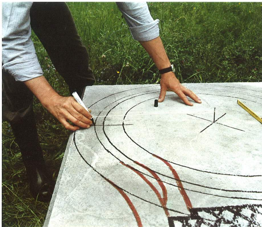
Abb. 11: Mit Hilfe einer Schnur lassen sich sehr leicht exakte Kreise ziehen.
