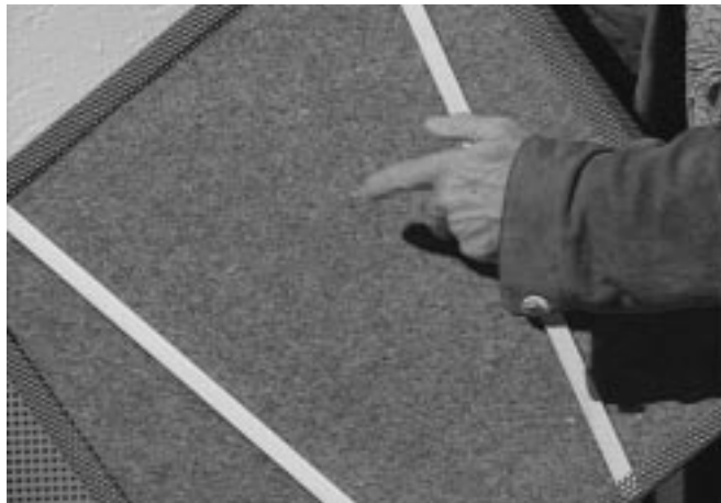
Die Rückseite eines Schafwollmoduls. Das Vlies wird an der Frontseite durch eine dekorative Lochplatte verdeckt
